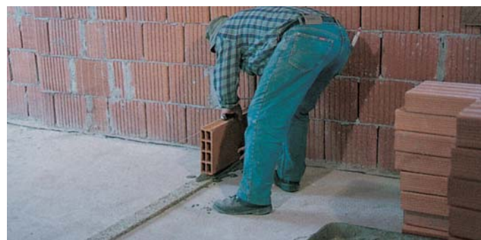
Tramezza isolata con una striscia di pannello Celenit N: intervento semplice ma efficace per interrompere la trasmissione dei rumori ai piani inferiori e ai locali adiacenti.
